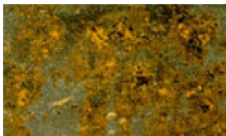
Basis. Stål med glødeskall og begynnende rustdannelse
